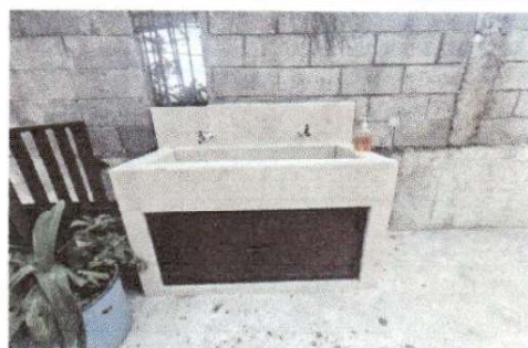
Foto 3: Lavamanos de cemento.
