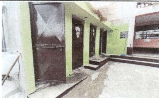
Foto 1: Puertas de baños colocadas y pintadas.
