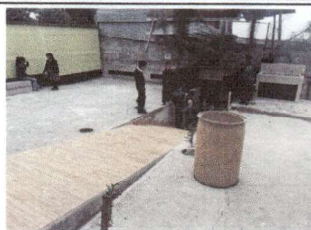
Foto 2: Piso de cemento terminado.
