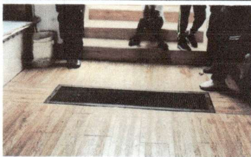
Foto 10: Cambio de rejilla,
