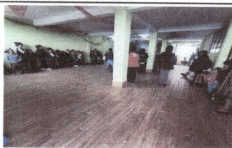
Foto 6: Piso del salón nuevo.
